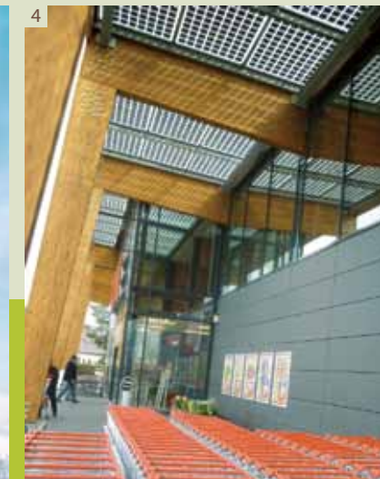
» Módulos semitransparentes com células de silício cristalino
